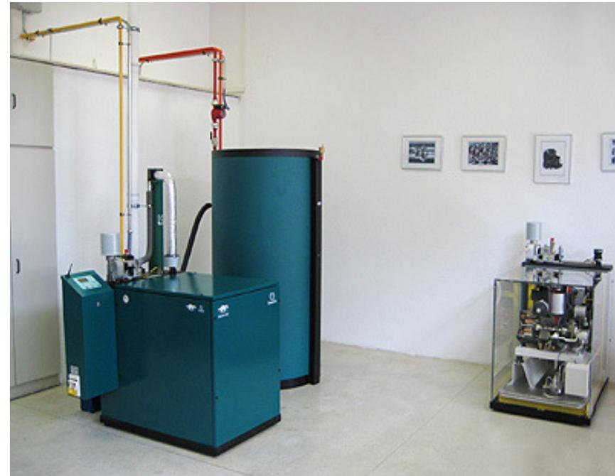
**MICROGENERACIÓN: electricidad para zonas comunes y calor para producción de ACS y calefacción.**
